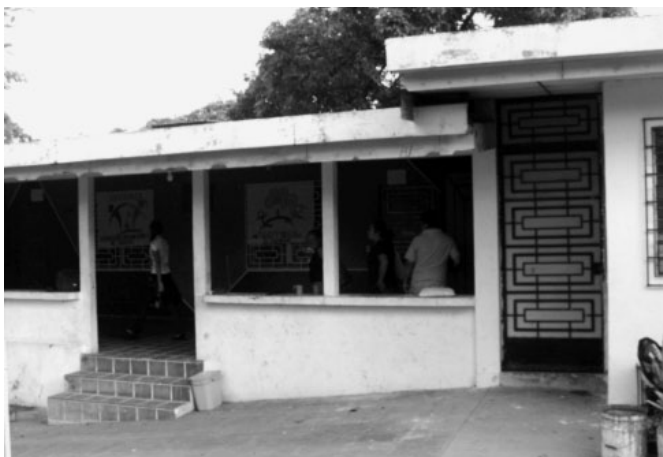
Der heutige Eingang führt über drei Stufen ins Haus. Neu wird ein rollstuhlgängiger Zugang mit Rampe und Handlauf bei der grün-blauen Türe hineinführen.
