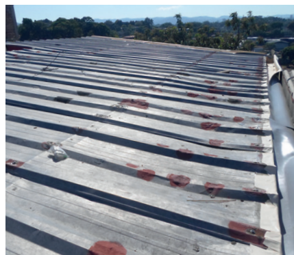
Dach des Hauses von Nueva Vida vor der Sanierung
