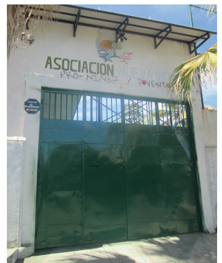
Eingang von Nueva Vida nach der Renovation mit einem nun richtig schliessenden Tor.
