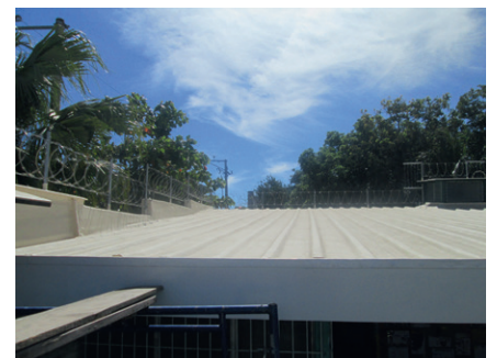
Dach nach der Sanierung mit Sicherheitszaun
